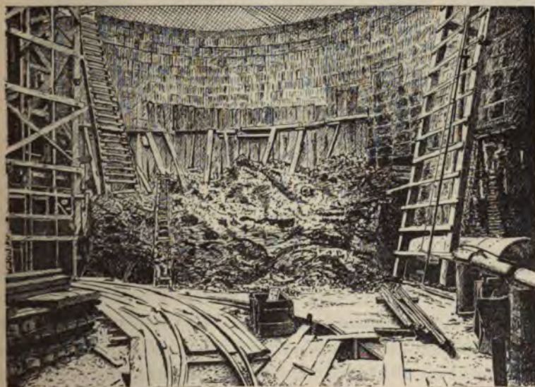
Fig. 138. — Puits sud. — Blindage provisoire de la partie inférieure.
